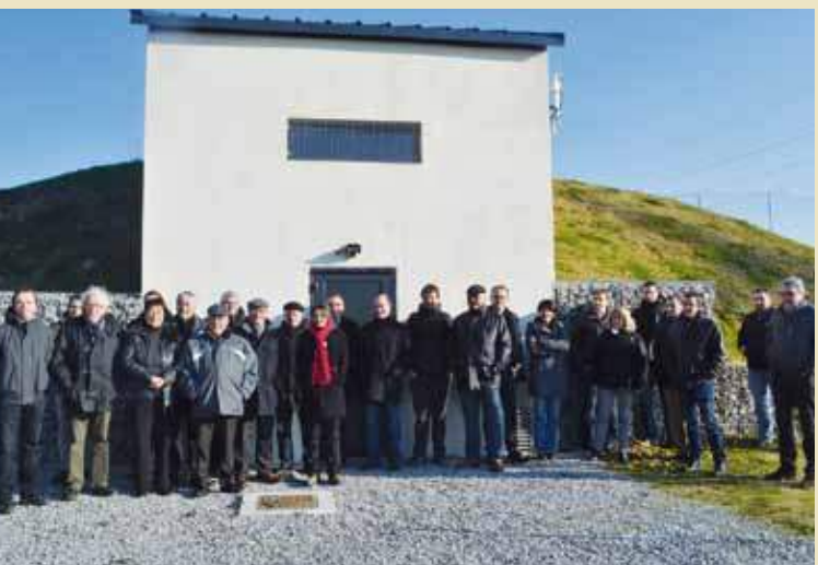
28 novembre - Visite des élus du syndicat mixte au nouveau réservoir d'eau potable de Lardet.
